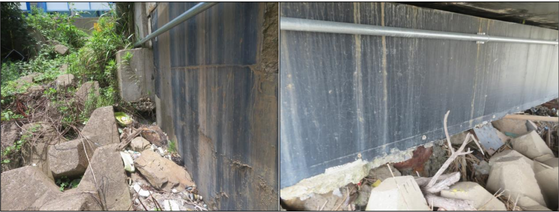
图 6.7-2 3 万吨级液体化工码头接岸结构外观检测结果
