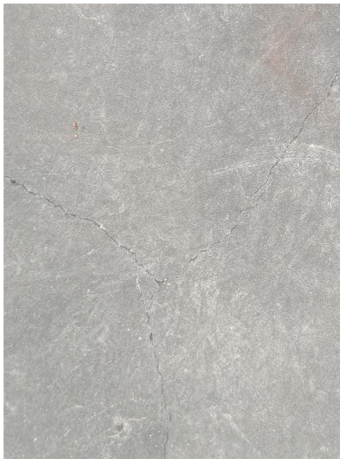
(9) 10#系缆墩开裂、锈蚀
