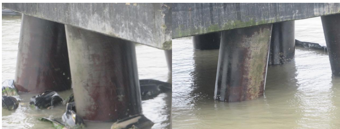
(3) 9#系缆墩桩基涂层脱落
