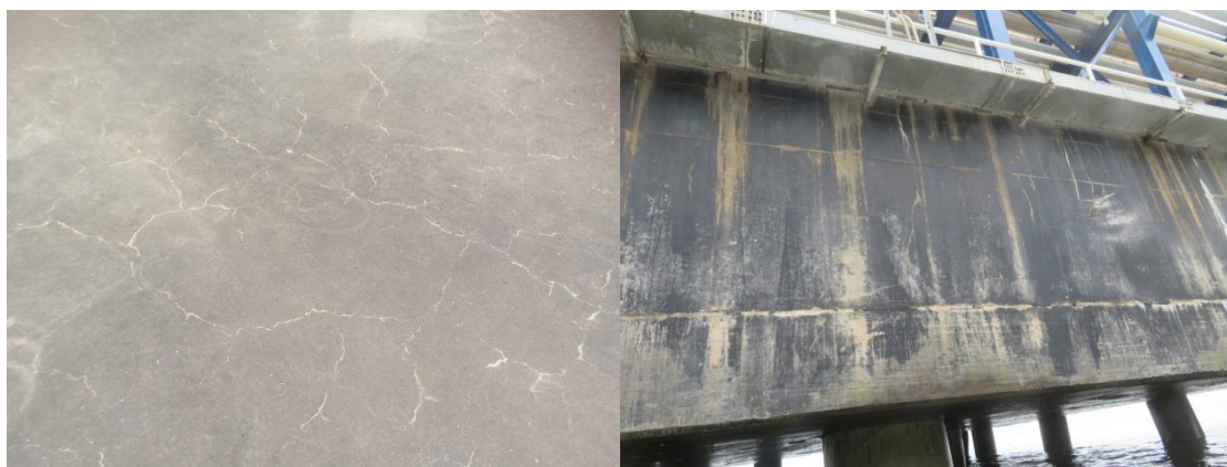
(6) 3万吨级工作平台开裂
