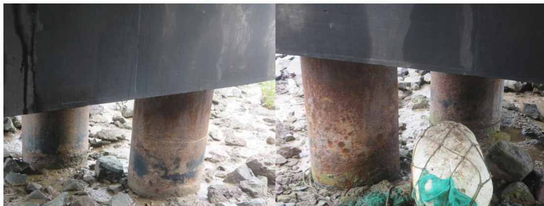
(1) 引桥钻孔灌注桩钢套筒普遍锈蚀
