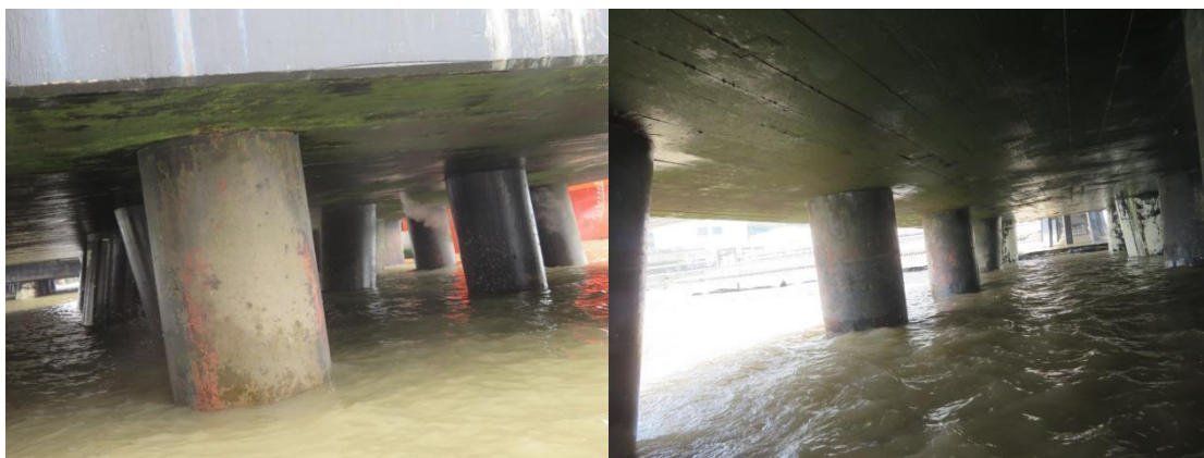
(6) 4#系缆墩墩桩基涂层脱落、开裂
