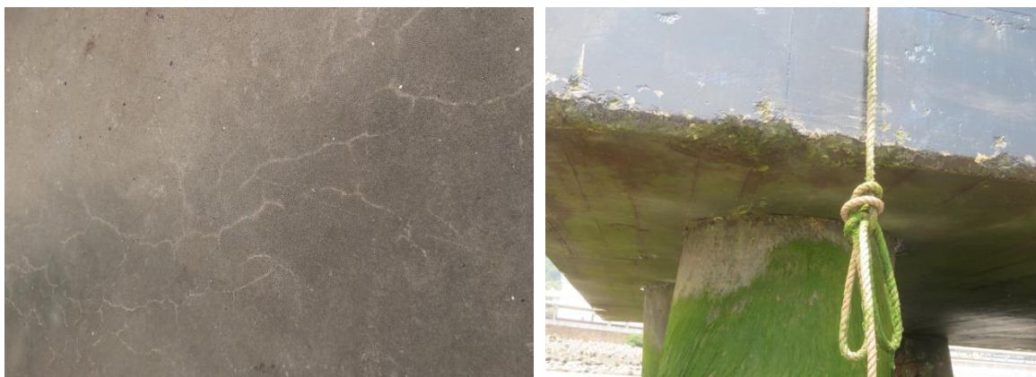
(1) 1#系缆墩破损、开裂
