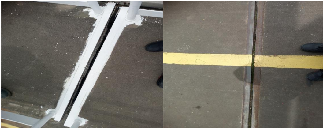
(1) 伸缩缝部分填充物缺失、高差
