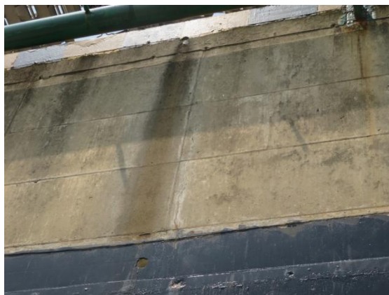
(6) 万吨级工作平台开裂
