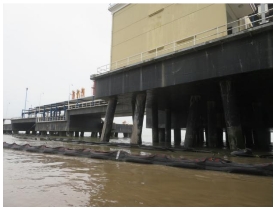
(4) 综合楼桩基涂层脱落
