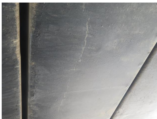
(2) 引桥 2~3#排架面层开裂
