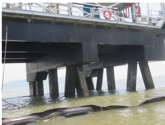
(2) 工作平台桩基涂层脱落、开裂
