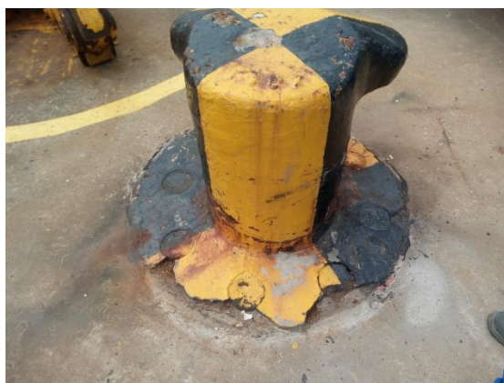
(1) 1#系缆墩基础局部混凝土破损
