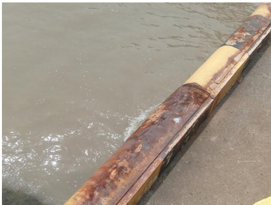
(8) 8#靠船墩开裂、锈蚀
