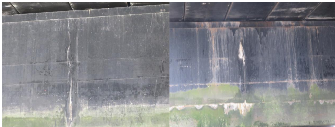
(4) 5#靠船墩开裂、破损
