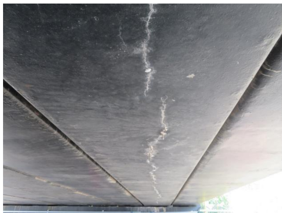
(1) 引桥 1~2#排架面层开裂
