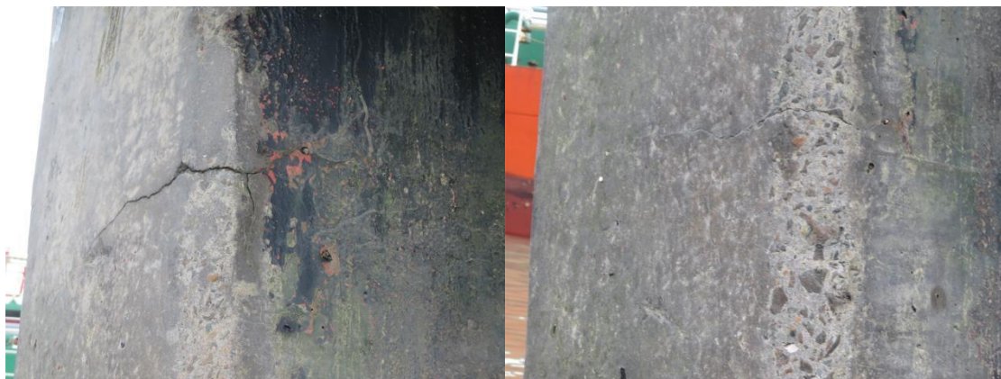
(1) 5#系缆墩桩基开裂
