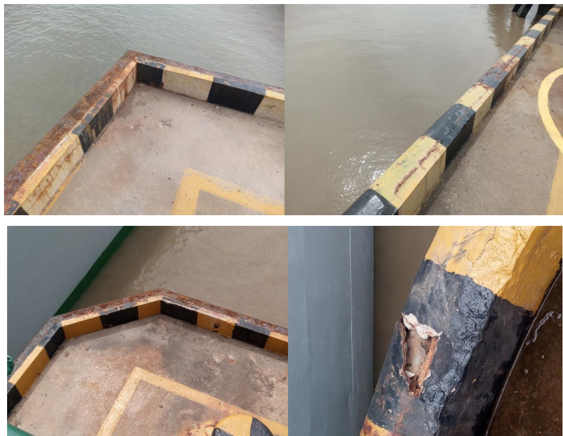
(1) 部分护轮坎锈蚀破损
