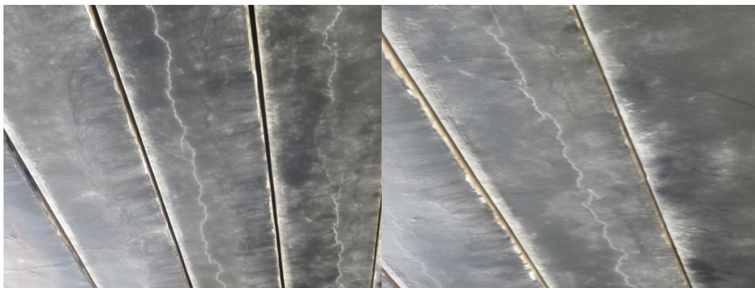
(1) 面层破损图（5万吨级油品码头检测结论）
