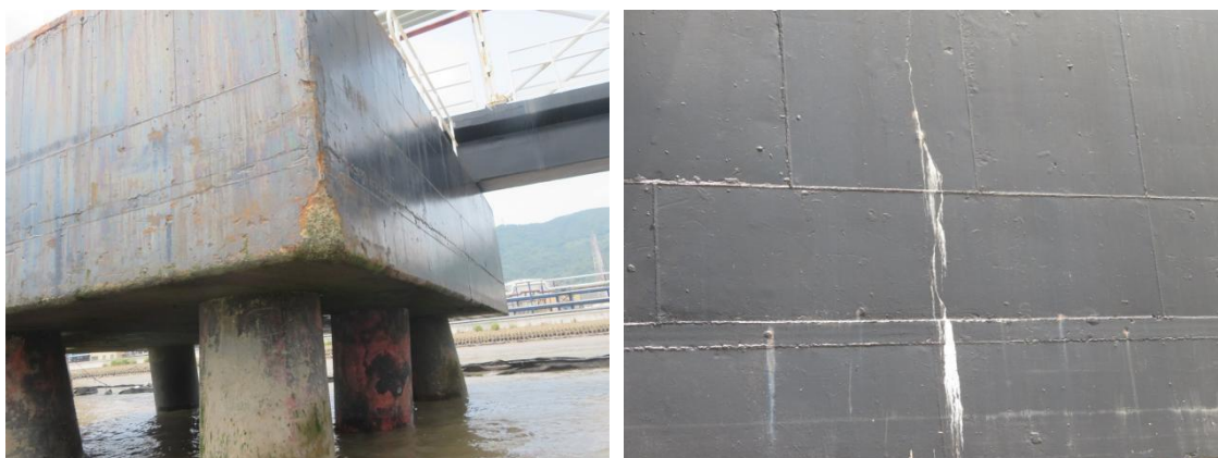
(8) 4#靠船墩破损、开裂
