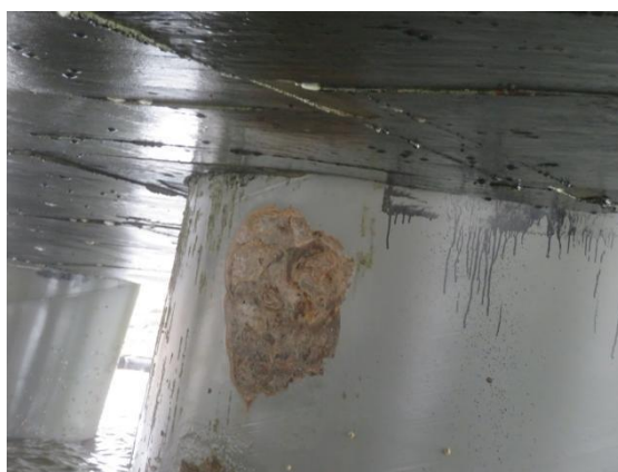
(5) 7#靠船墩 9#钢管桩涂层脱落、锈蚀
