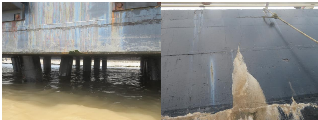
(8) 4#靠船墩破损、开裂
