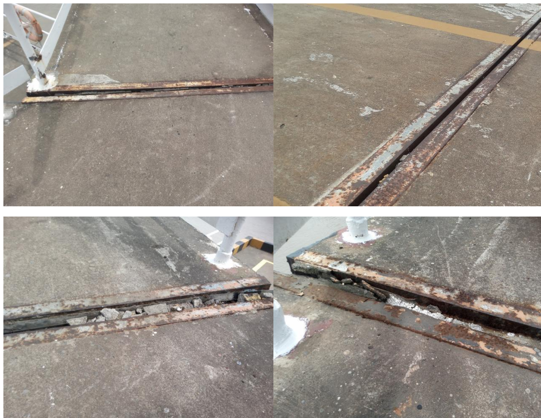
(1) 部分伸缩缝填充物缺失、高差
