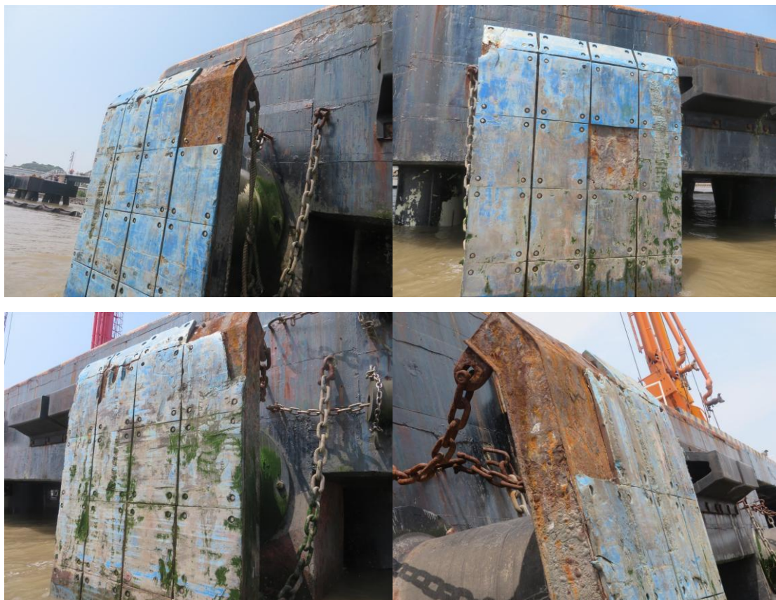
(1) 部分护舷靠船板破损、缺失、锈蚀、铁链锈蚀
