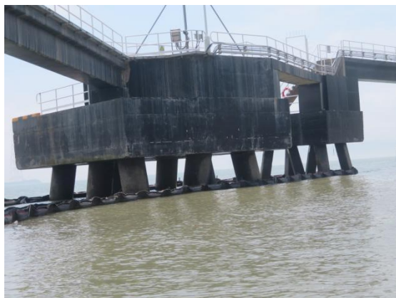
(1) 8#系缆墩桩基涂层脱落
