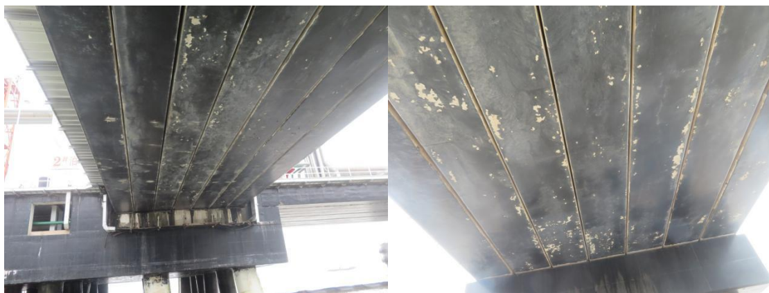
(3) 引桥面板局部涂层脱落
