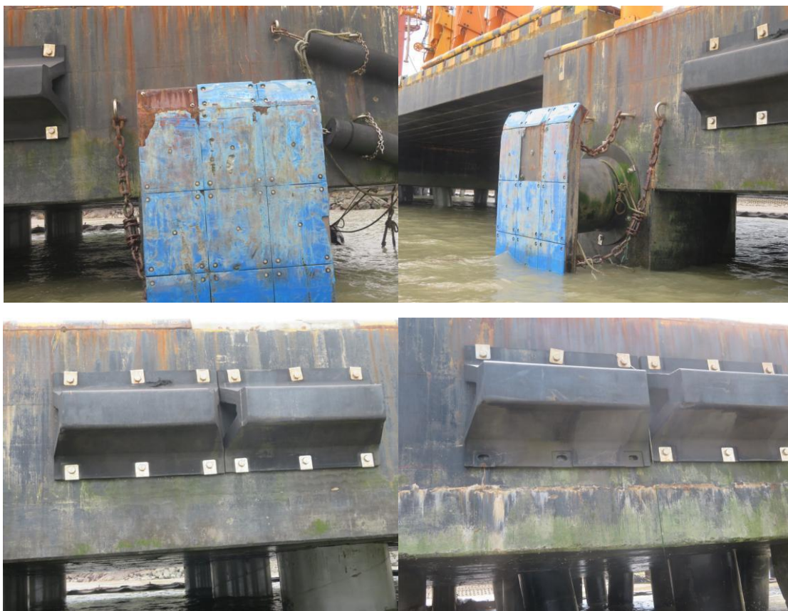
(1) 护轮坎靠船板、螺帽部分缺失、护舷局部破损
