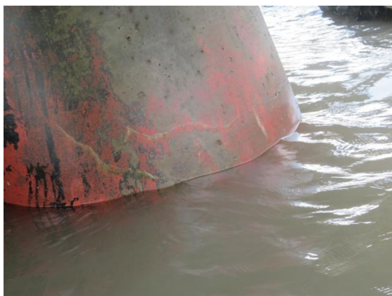
(1) 1#靠船墩桩基涂层脱落、开裂
