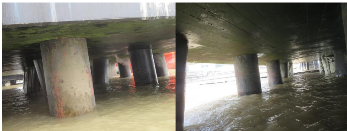
(3) 工作平台桩基涂层脱落
