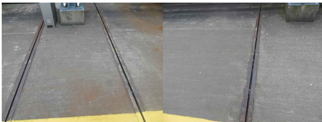
(1) 引桥伸缩缝填充物缺失
