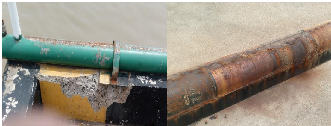
(1) 护轮坎锈蚀、混凝土破损
