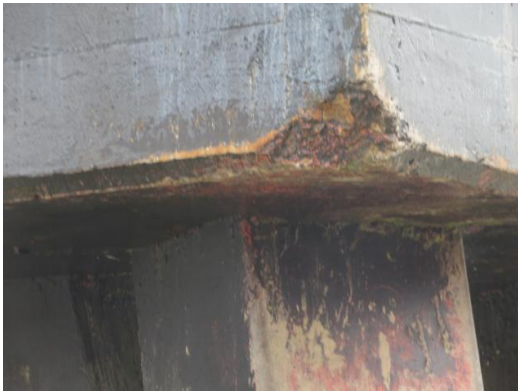
(1) 6#系缆墩破损情况 (3 千吨级油品码头检测结论)
