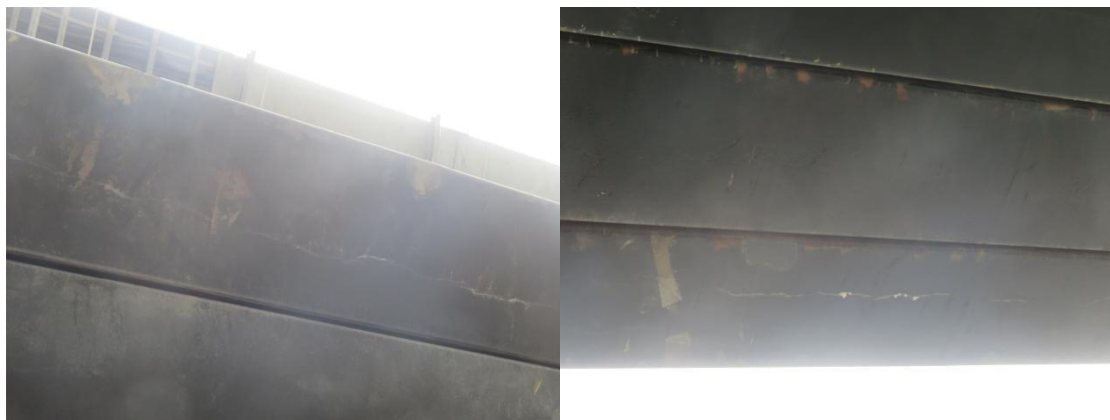
(5) 引桥 5~6#排架面层开裂
