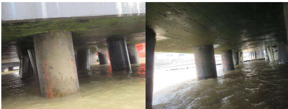
(5) 2#人行桥墩桩基破损
