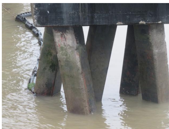
(3) 6#系缆墩桩基涂层脱落
