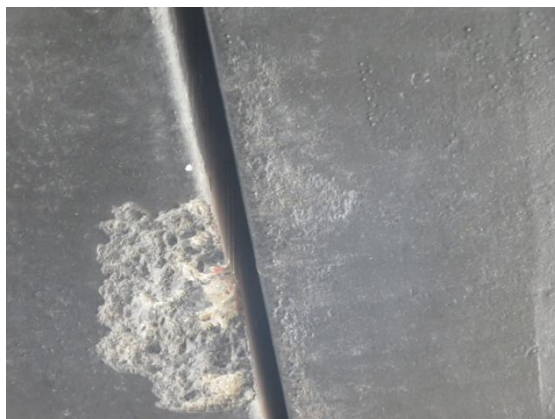
(1) 7#靠船墩~8#靠船墩间工作平台面层破损（3万吨级液体化工码头检测结论）
