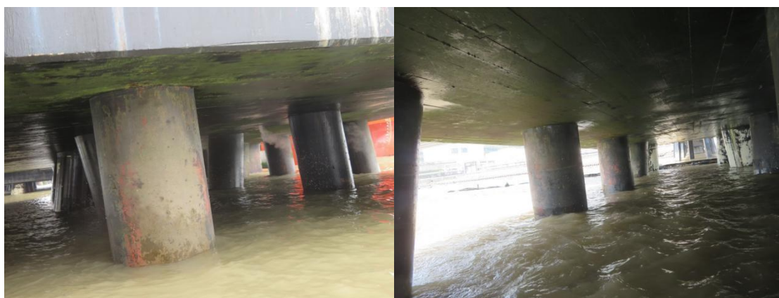
(3) 工作平台桩基涂层脱落
