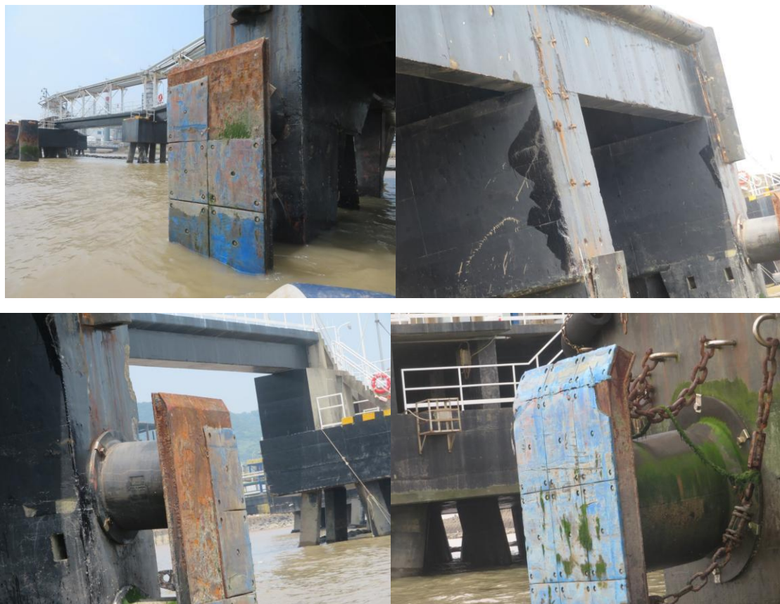
(1) 护舷靠船板缺失、锈蚀；铁链锈蚀、断裂
