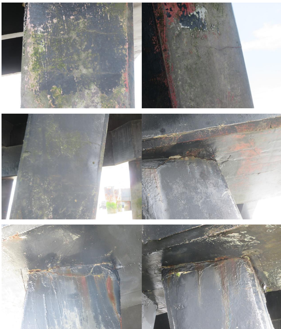
(1) 5#系缆墩桩基开裂
