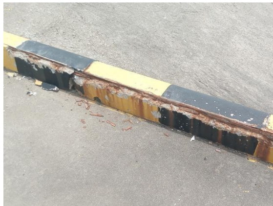
(8) 8#靠船墩开裂、锈蚀
